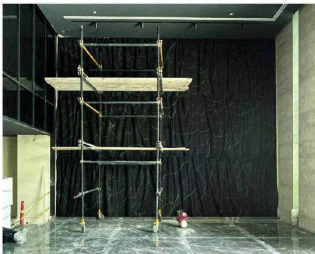
● اجرای زیرسازی دیوار سبز
